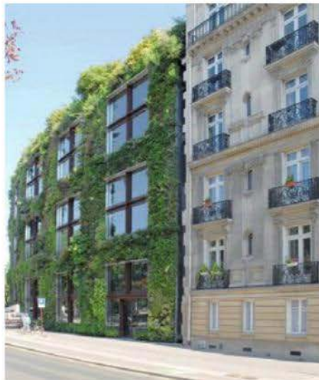
Figure 1 : Mur végétalisé sur domaine public
