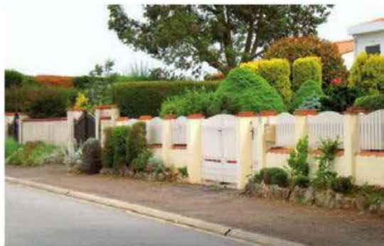
Figure 14 : Végétalisation des pieds de mur
