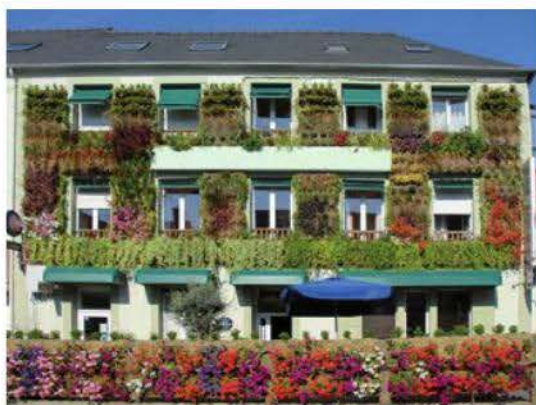
Figure 13 : Mur végétalisé en modules
