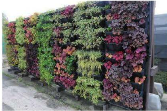
Figure 6 : Présentation des modules préformés pour mur végétalisé
