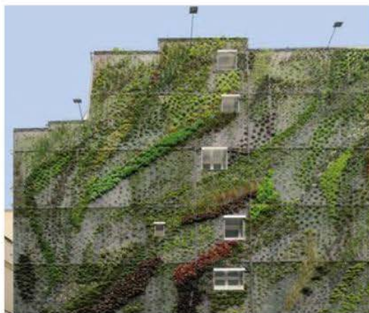
Figure 12 : Mur végétalisé en nappe
