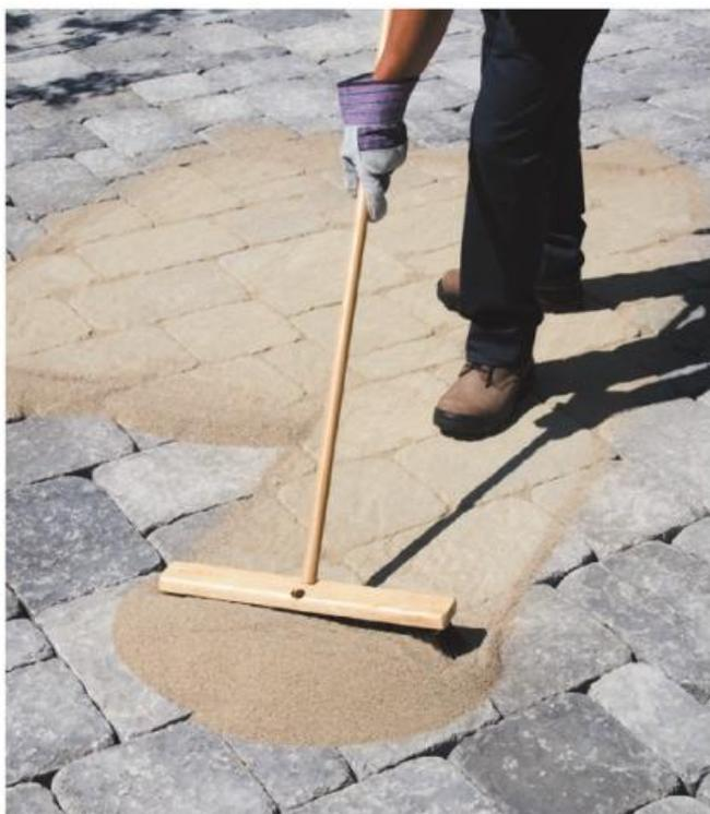
**Étape 1 : Remplissage.** Le sable polymère DR+ se pose à sec avec un balai. Les joints doivent être entièrement remplis.
