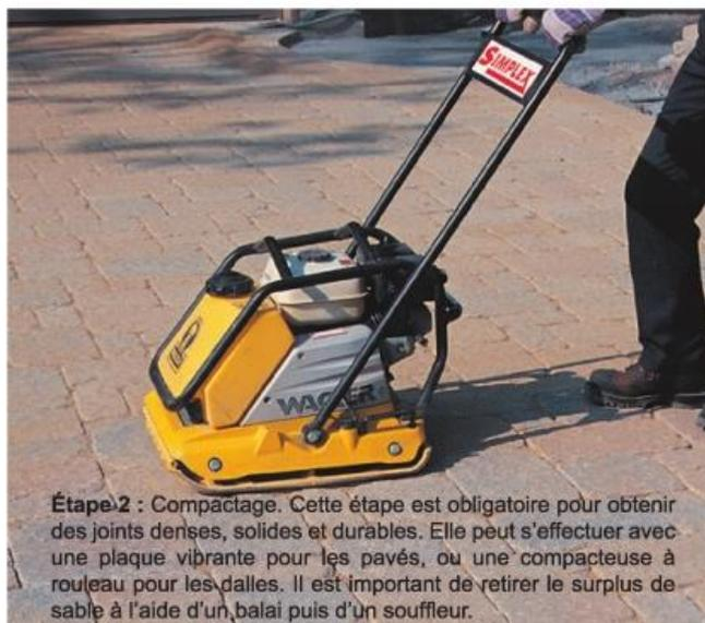
**Étape 2 : Compactage.** Cette étape est obligatoire pour obtenir des joints denses, solides et durables. Elle peut s'effectuer avec une plaque vibrante pour les pavés, ou une compacteuse à rouleau pour les dalles. Il est important de retirer le surplus de sable à l'aide d'un balai puis d'un souffleur.
