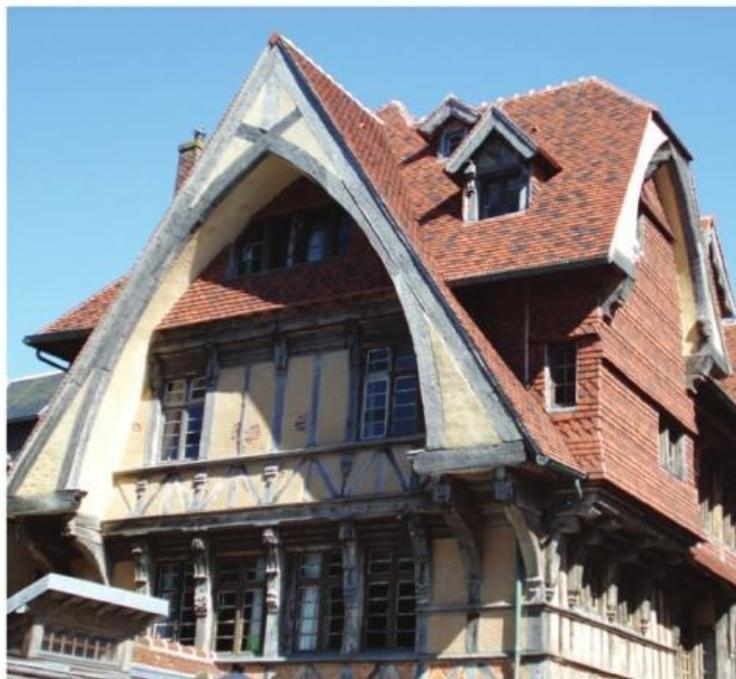
**Ci-dessus :** La Pommard : une tuile d'exception grâce à sa technique de pressage qui lui donne une forme et un grain uniques. Le mélange des terres sélectionnées lui assure une parfaite résistance au gel et aux intempéries (Terreal).
