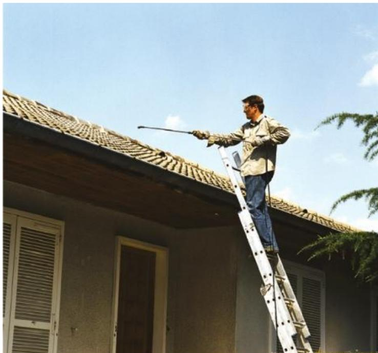
**Ci-dessus** : Pour les traitements en hauteur jusqu'à 7 m et l'application de produits anti-mousse ou de produits agressifs, le Seringa de Berthoud est un pulvérisateur à seringue équipée d'une pompe double action. Elle fonctionne dans les 2 sens (aller/retour) pour permettre le pompage du produit en continu et délivre une pression de service élevée de 4 à 5 bars suivant le rythme de pompage.
