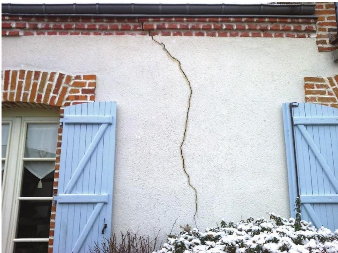
**F**issures, affaissements ou encore vides sous plinthes sont des signes qui mettent en évidence un défaut de portance du sol présent sous votre habitation. Bien qu'impressionnant, il existe une solution et les injections de résine expansive peuvent y remédier. Les injections de résine expansive sont une nouvelle
