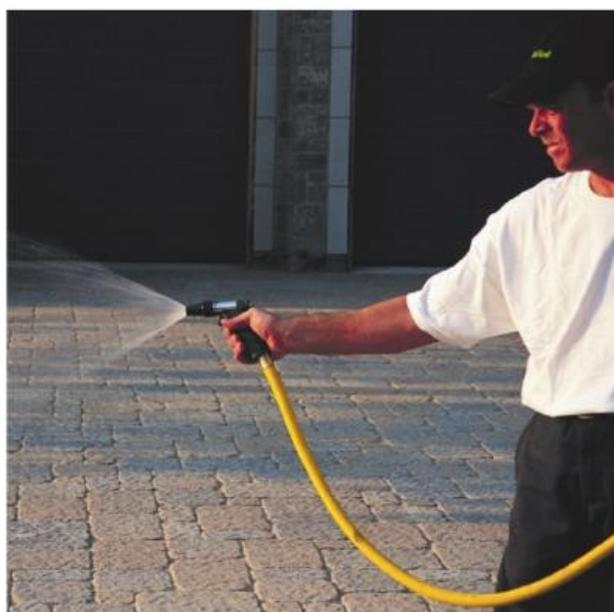
**Étape 3 : Mouillage.** Un arrosage au jet permet au sable de se polymériser. Le joint s'arrose jusqu'à refus car il n'absorbe que l'eau nécessaire à son activation. Il suffit d'évacuer au souffleur le surplus d'eau resté en surface et les poussières restées en suspens.
