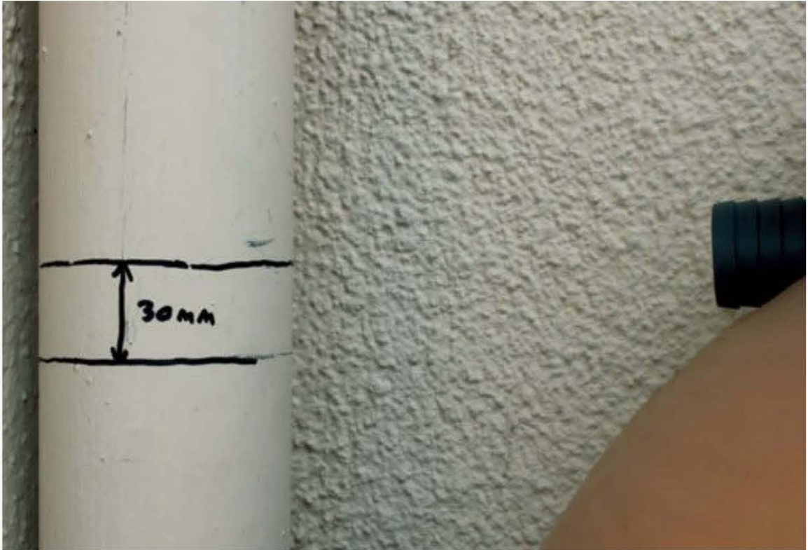
Fig. 2.7 – Mesure des marques de découpe
