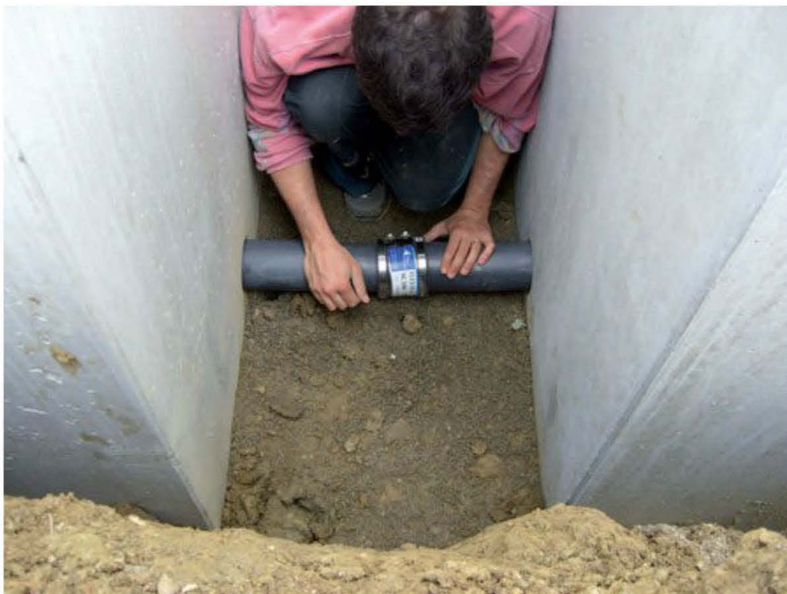
Fig. 2.14 – Liaison entre deux cuves
