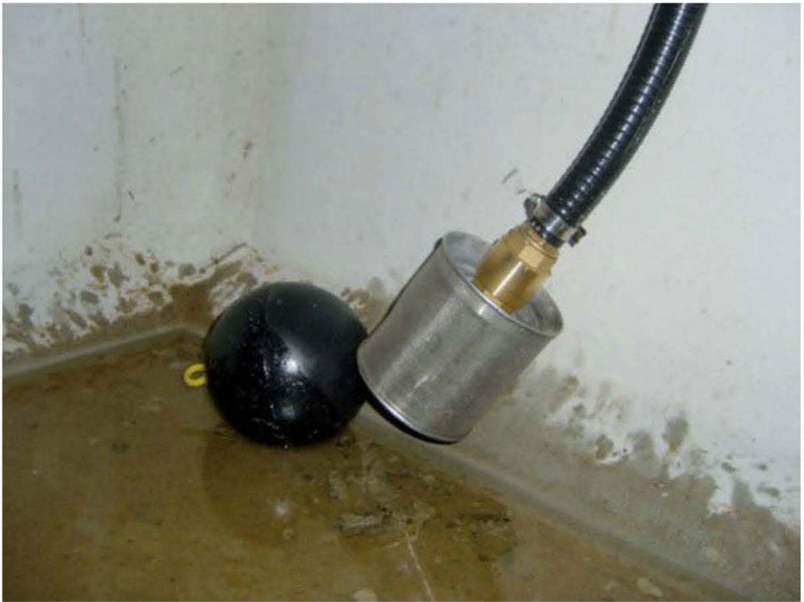
Fig. 3.4 – Crépine d'aspiration de maille 0,3 mm
