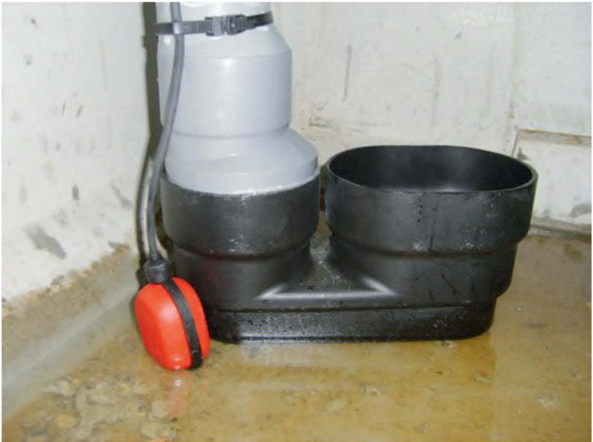
Fig. 3.2 – Dispositif anti-remous
