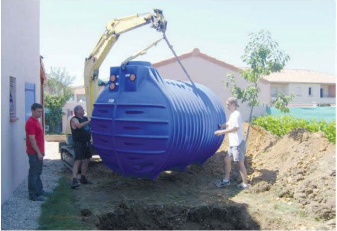
Fig. 2.17 – Pose d'une cuve polyéthylène de 9 000 L
