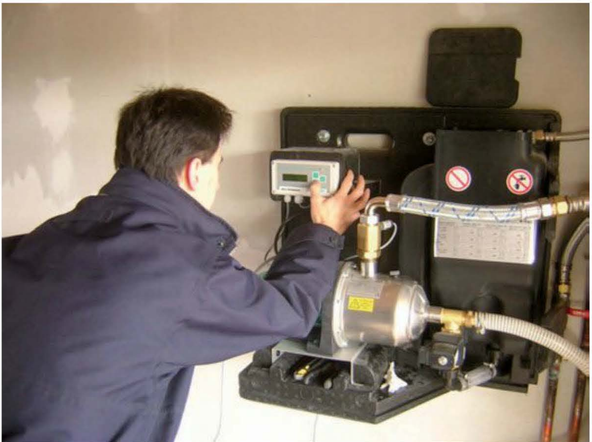
Fig. 4.6 – Mise en service d'une pompe de gestion
