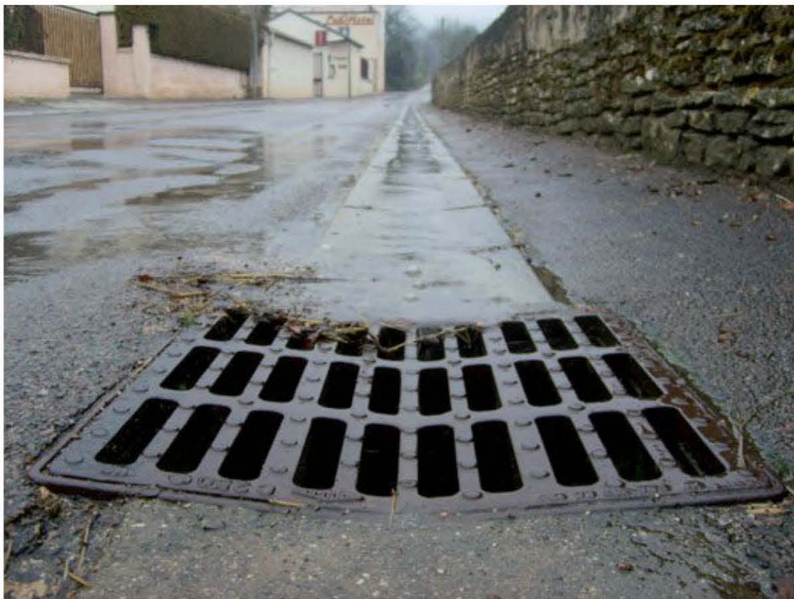
Fig. 7.1 – Évacuation des eaux de ruissellement
