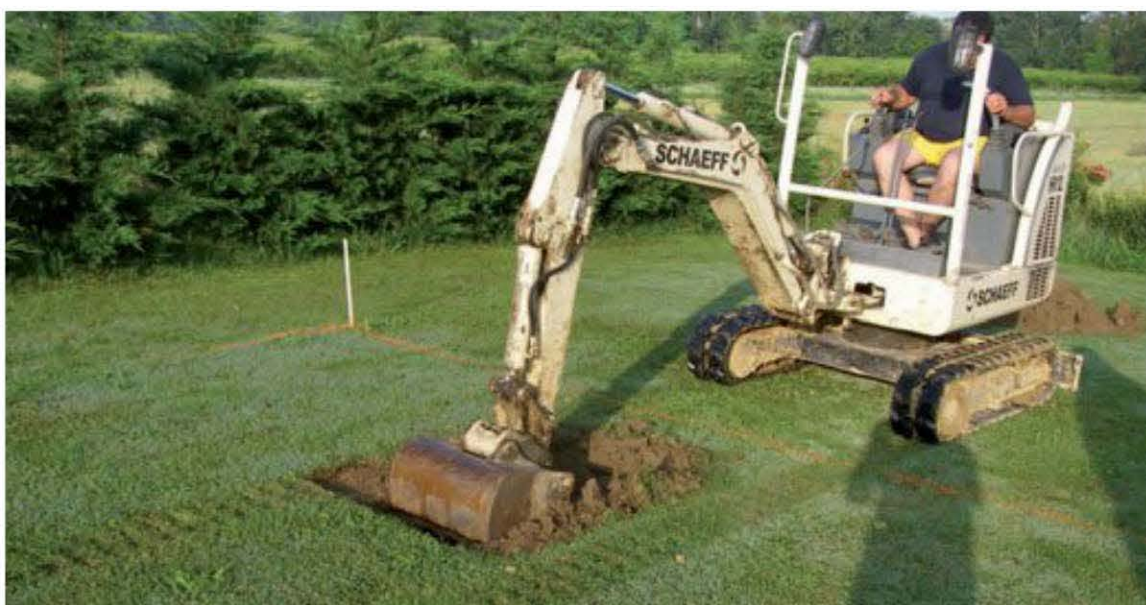
Fig. 2.21 – Creusement de la fosse préalablement délimitée
