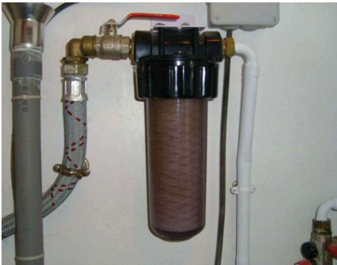
Fig. 1.3 – Filtration de l'eau de pluie
