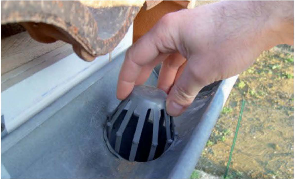
Fig. 7.3 – Crapaudine au sommet de la descente
