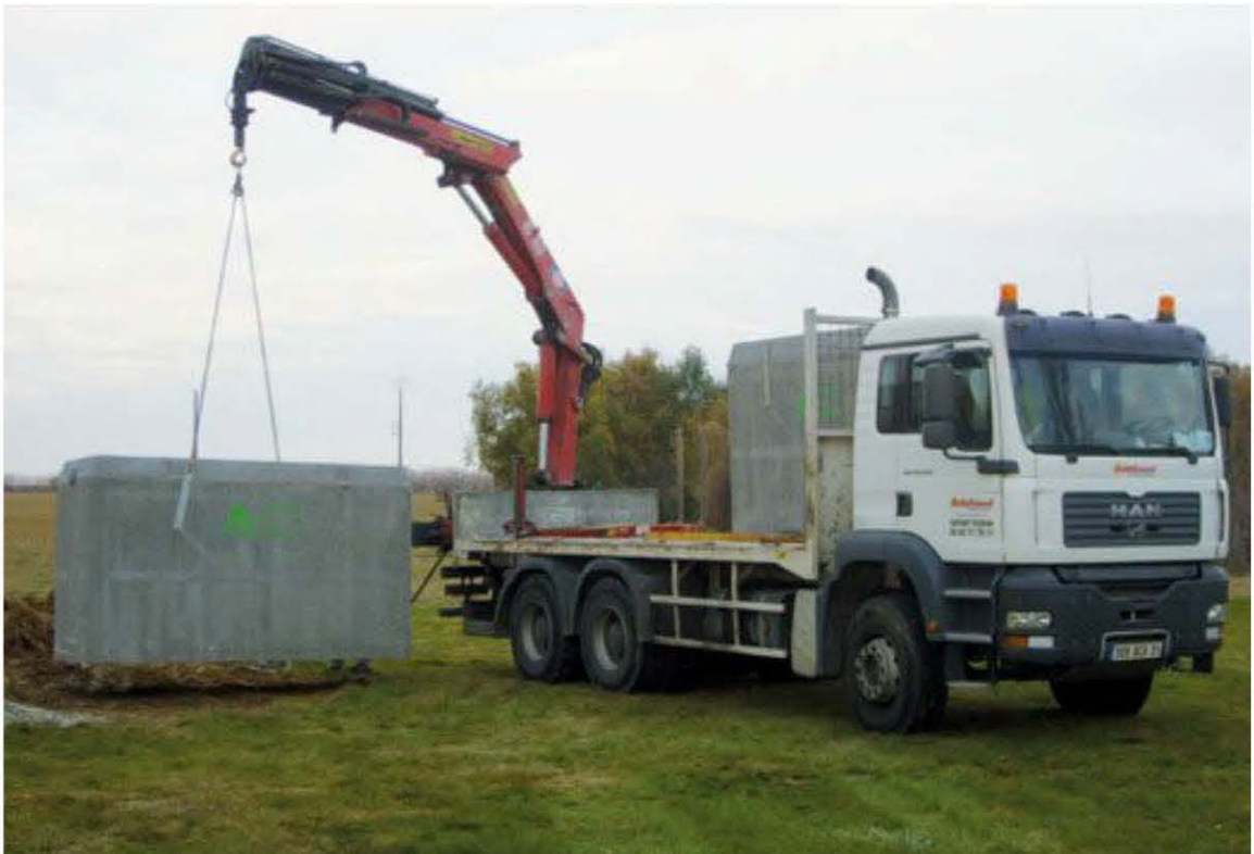
Fig. 2.12 – Déchargement d'une cuve en béton
