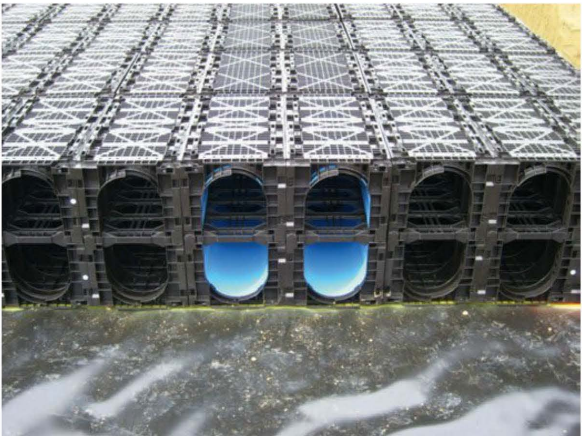
Fig. 7.9 – Modules d'épandages ou structures alvéolaires ultra-légère
