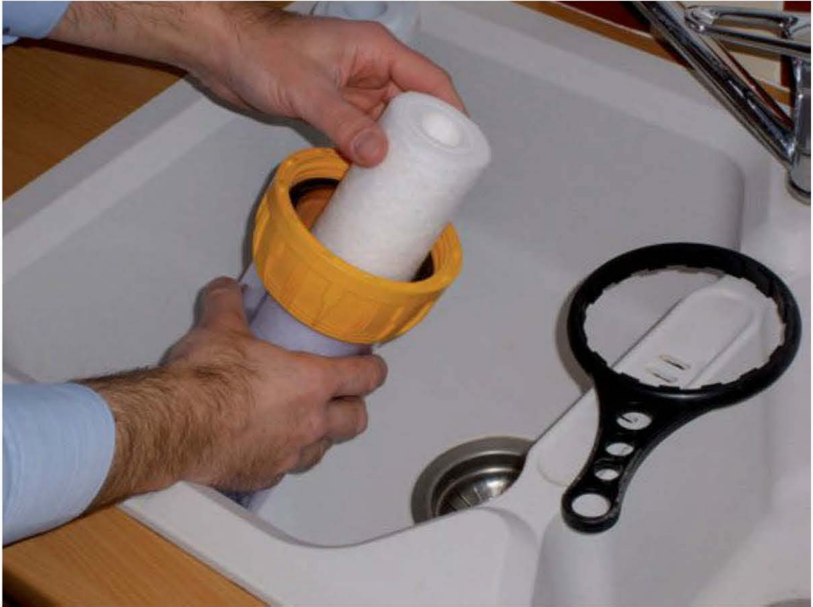
Fig. 6.2 – Remplacement d'une cartouche de filtration
