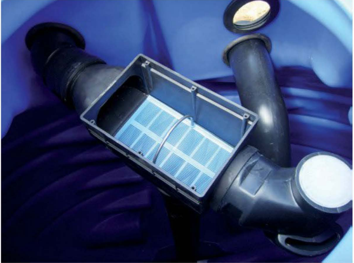
Fig. 3.10 – Préfiltre interne raccordé au trop-plein
