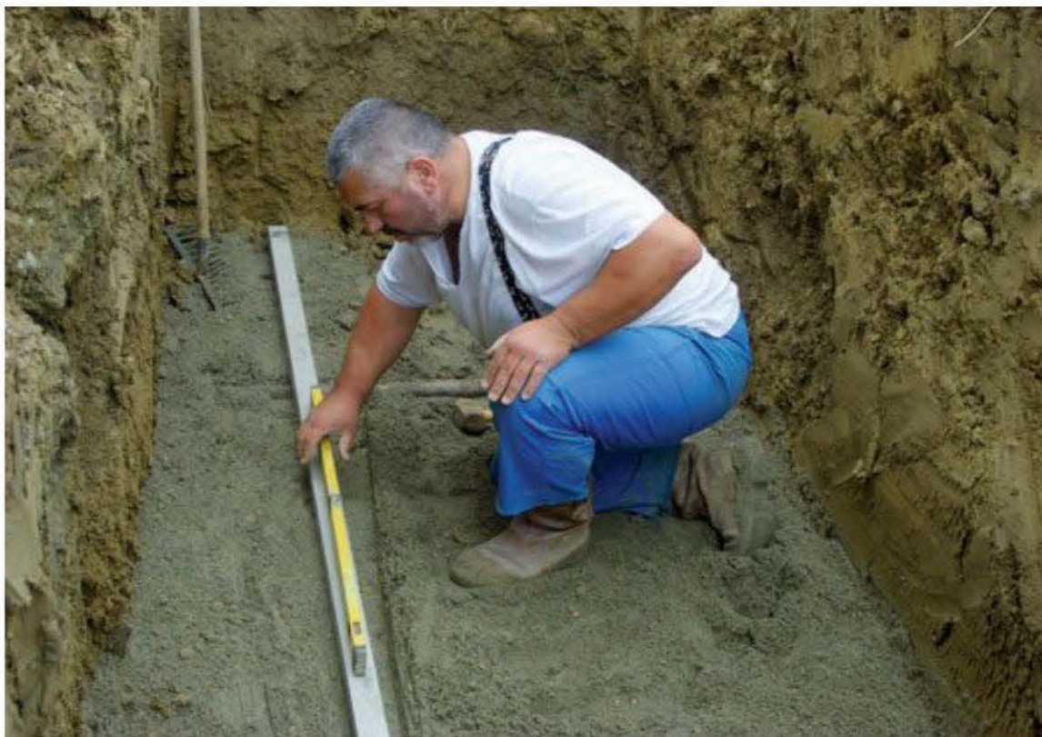
Fig. 2.22 – Préparation méticuleuse de la fosse
