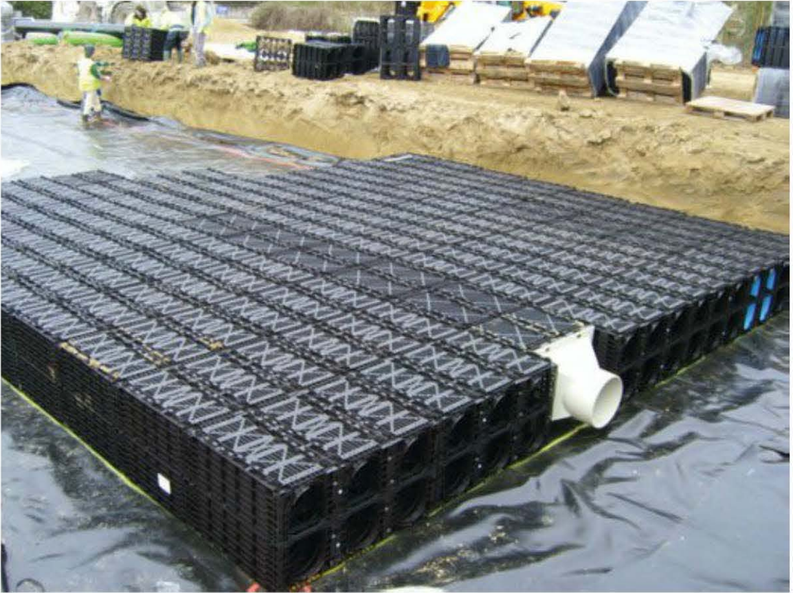
Fig. 7.18 – Mise en place de modules d'épandage
