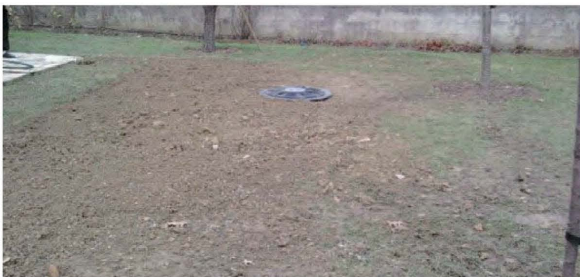
Fig. 2.24 – Installation finale d'une cuve plate F-Line de 5 000 L
