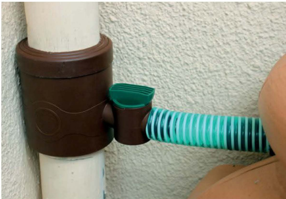
Fig. 2.9 – Installation du collecteur
