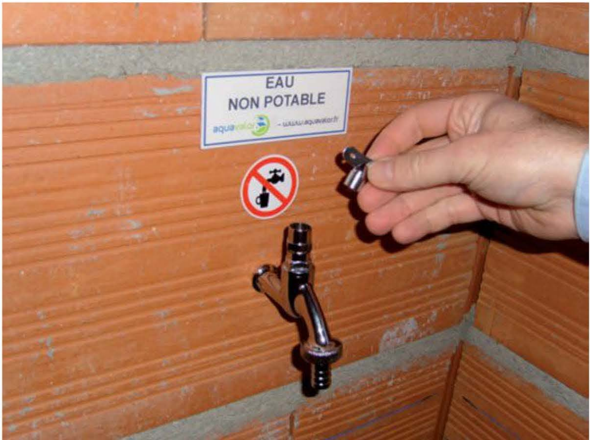
Fig. 3.11 – Robinet amovible avec signalétique
