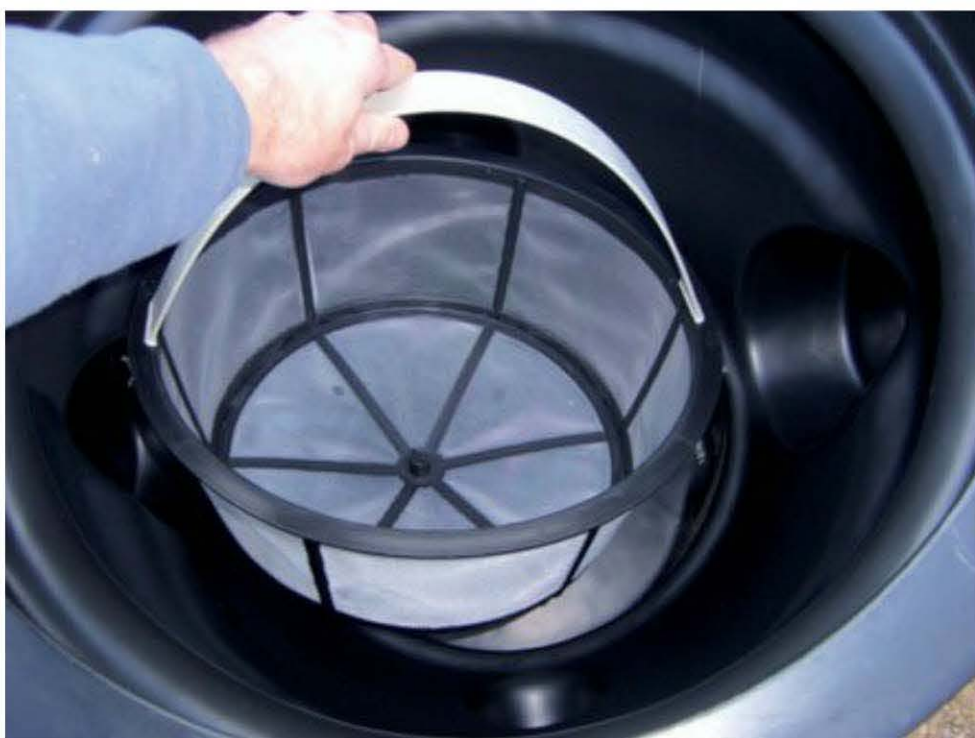
Fig. 7.7 – Regard de filtration à panier
