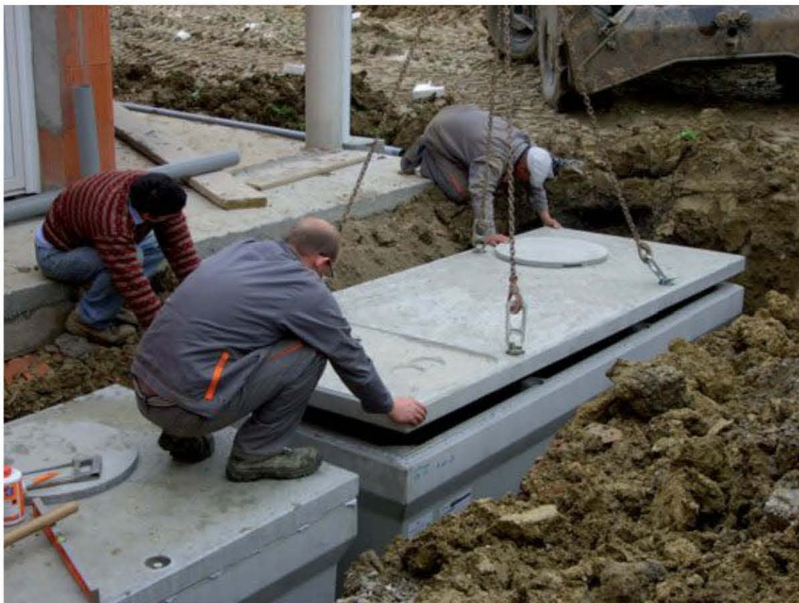
Fig. 10.3 – Assistance technique à la pose d'une cuve en béton
