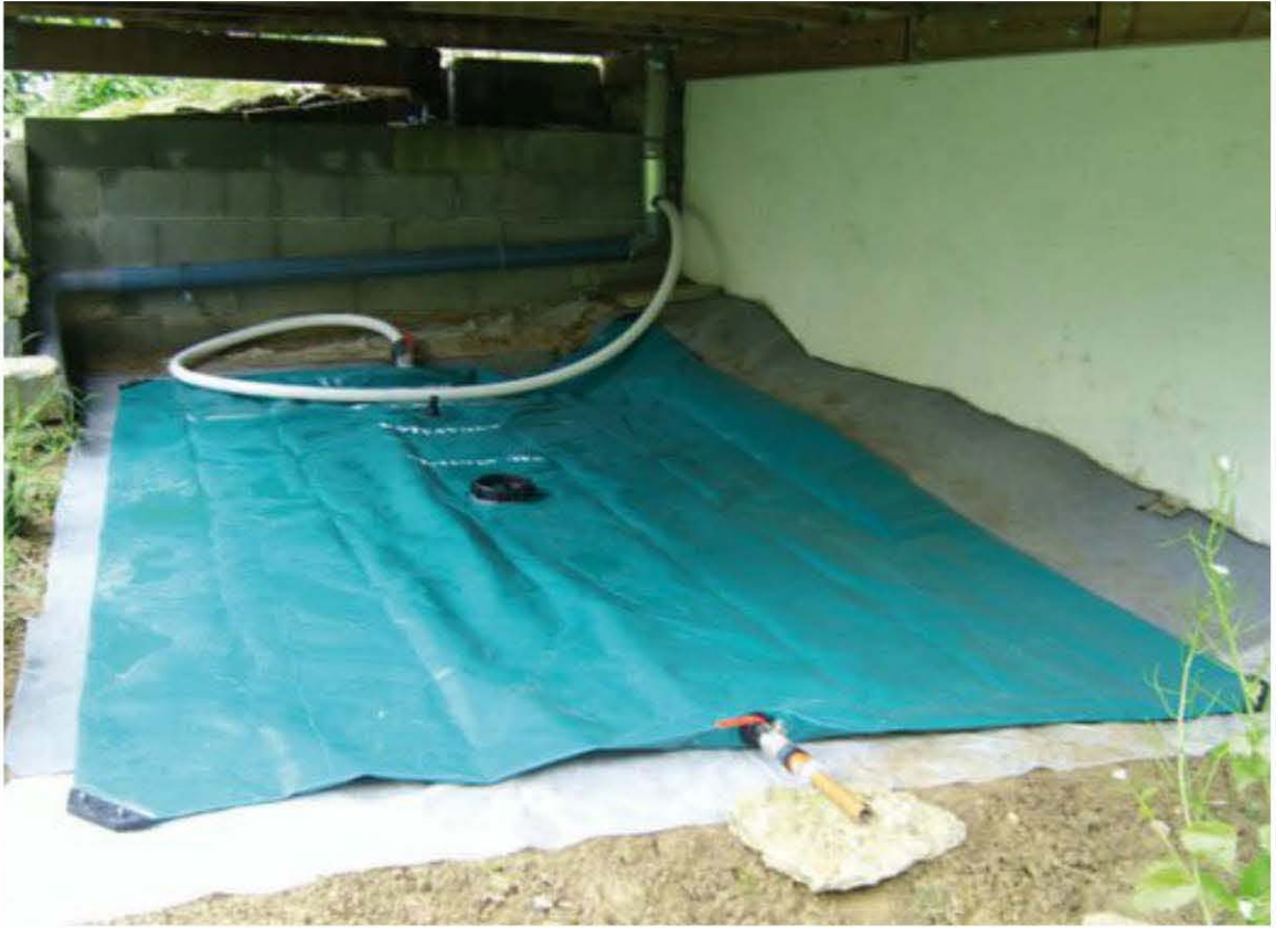
Fig. 2.10 – Installation d'une citerne souple sous une terrasse en bois
