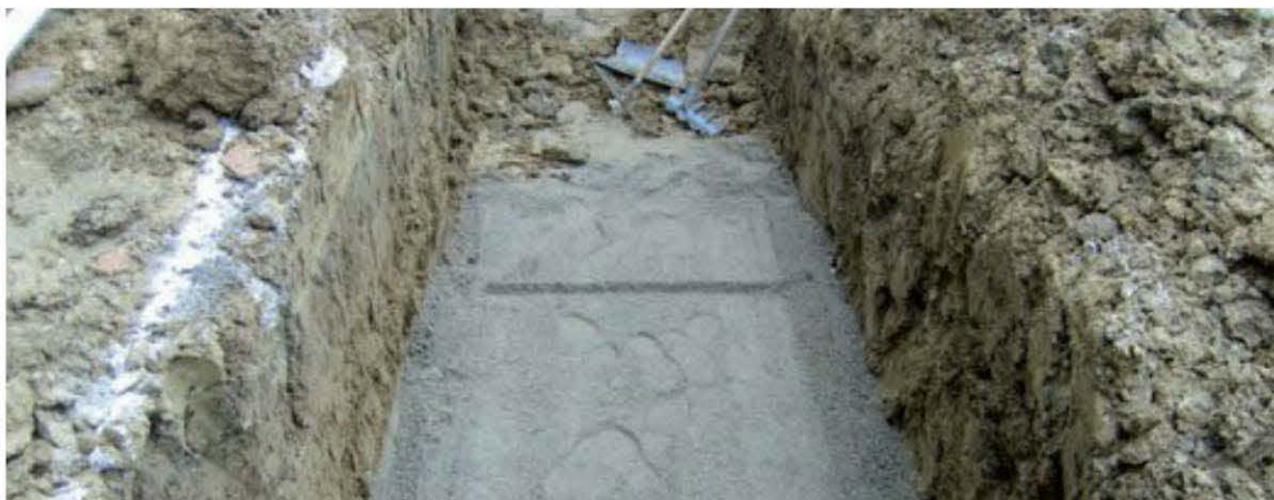
Fig. 2.23 – Le fond de fouille avant la pose de la cuve
