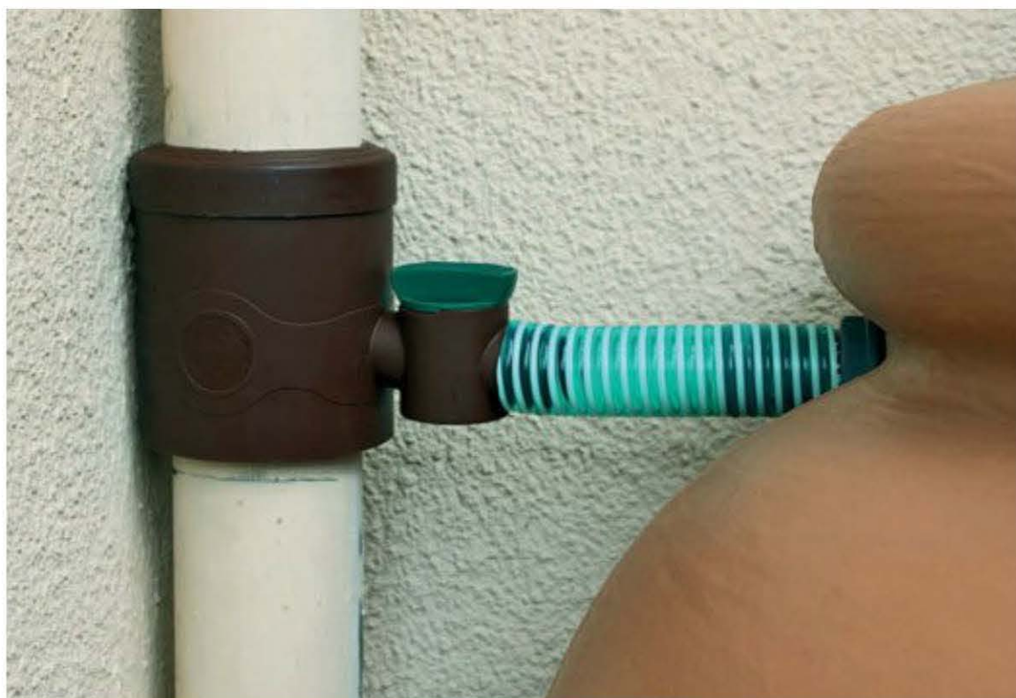
Fig. 2.4 – Collecteur filtrant d'eau de pluie
