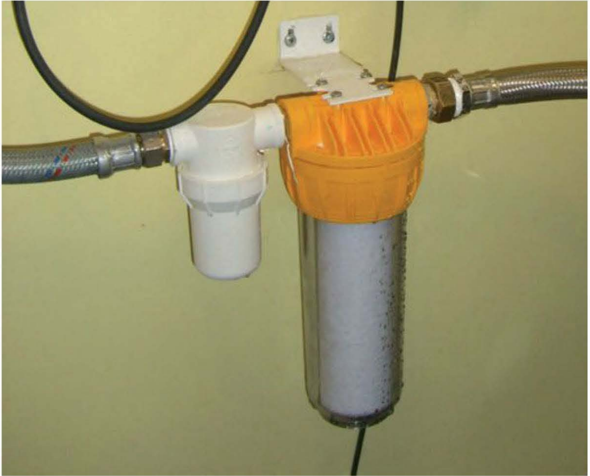
Fig. 6.1 – Filtre lavable 50 \mu\text{m} combiné à un filtre 25 \mu\text{m}
