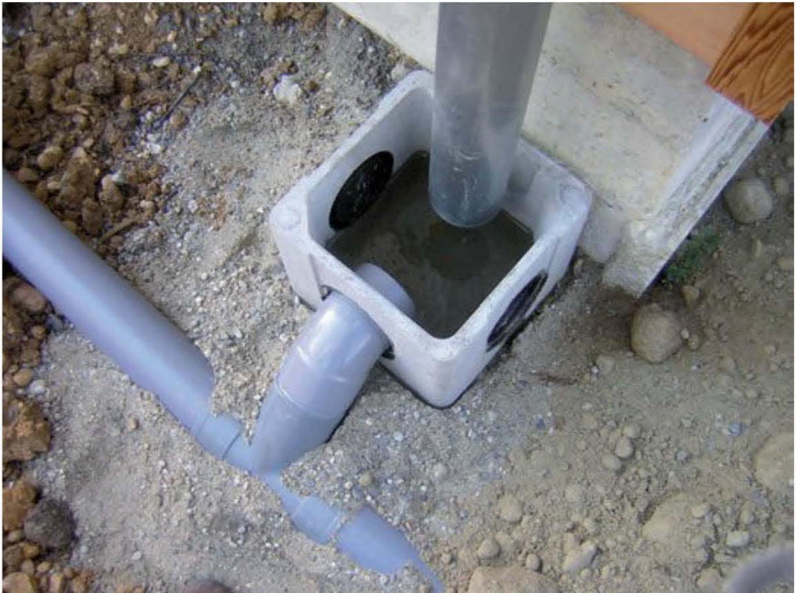
Fig. 7.2 – Connexion des descentes de gouttière au regard
