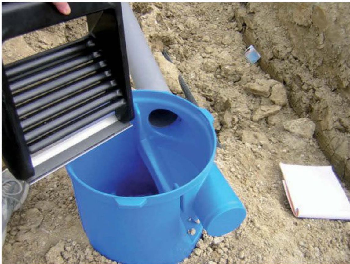
Fig. 3.9 – Préfiltre enterré autonettoyant
