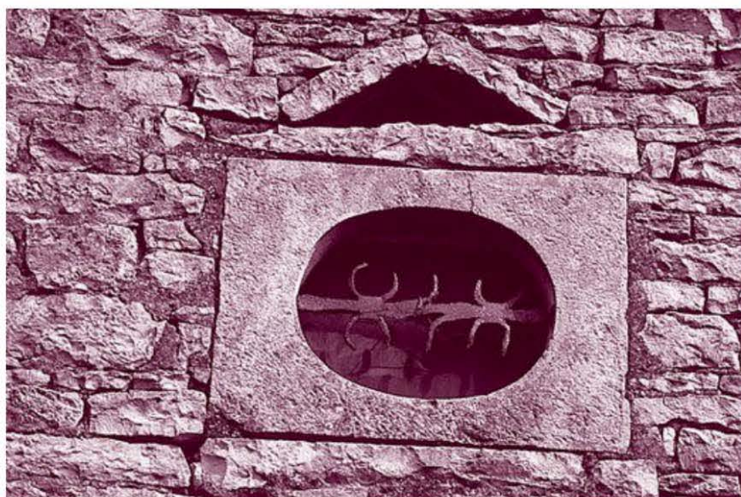
Fer « écorché » protégeant un jour de bâtiment agricole, en Bourgogne.
