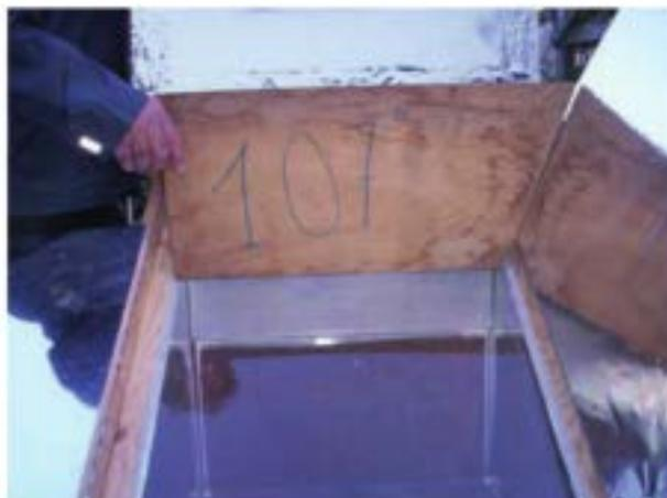
Pour maintenir le déflecteur sur un angle de 107° environ, reliez le tasseau du déflecteur avec le bras d'appui par une simple pointe.
