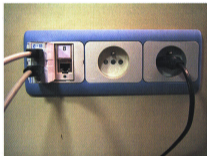
Figure 2.2.c. Boîtier avec 2 PC et 2 RJ 45 dont une attente et l'autre dupliquée
