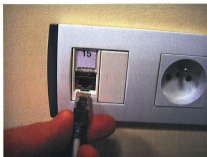
Figure 2.2.b. Connexion d'une fiche mâle RJ 45 d'un cordon de raccordement dans une prise murale femelle
