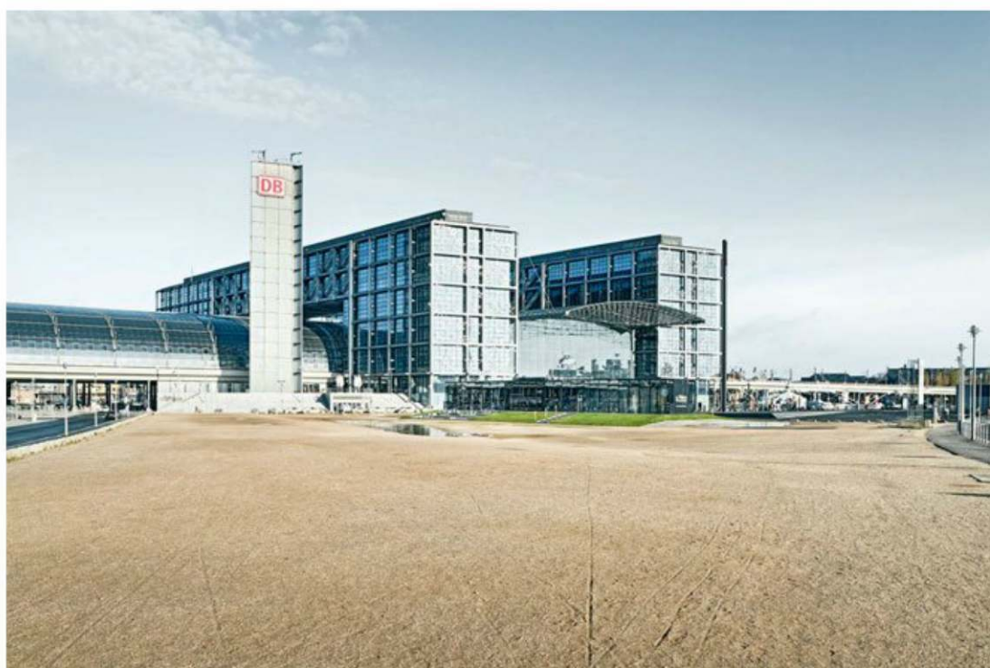
Fig. 2.57 – Là encore, le déplacement modifie totalement l'impact de l'image : la place paraît plus large et plus profonde, et elle connecte l'observateur à l'immeuble (longueur focale : 24 mm).
