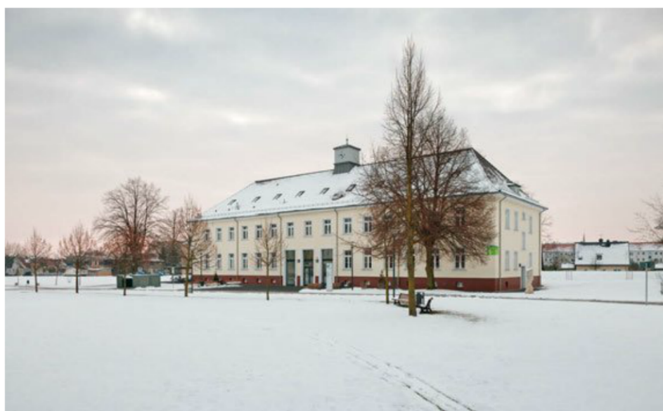
Fig. 1.43 – Les basses températures réduisent significativement la capacité des batteries.
