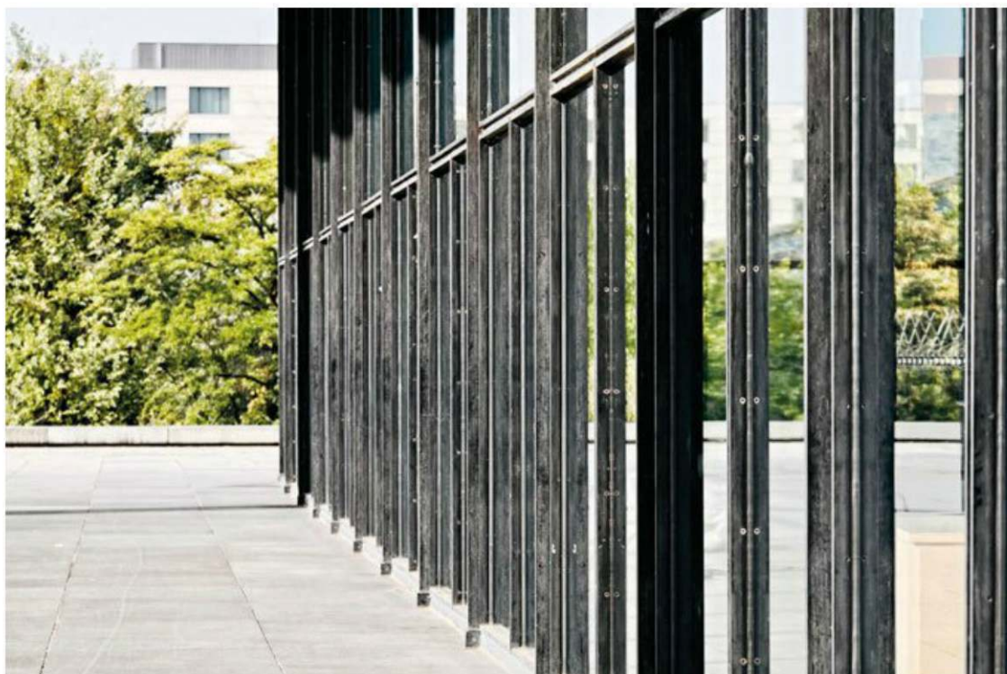
Fig. 2.52 – Ici, l'angle de l'appareil photo réduit l'espacement entre les éléments de la structure, donnant à la façade une apparence dure et fermée.
