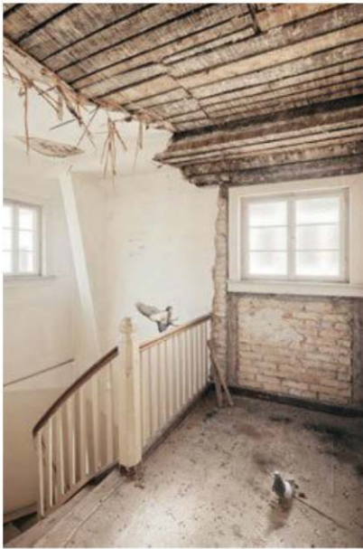
Fig. 2.11 – Un bâtiment ancien et délabré
