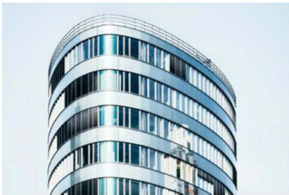
Fig. 2.46 – Photographié de loin, cet immeuble semble arrondi et élégant (longueur focale: 200 mm)
