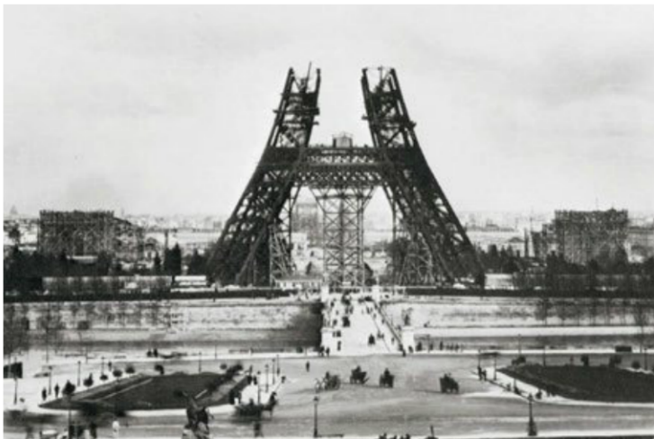
Fig. 12 – Pierre Petit, Construction de la Tour Eiffel, Paris, 1888
