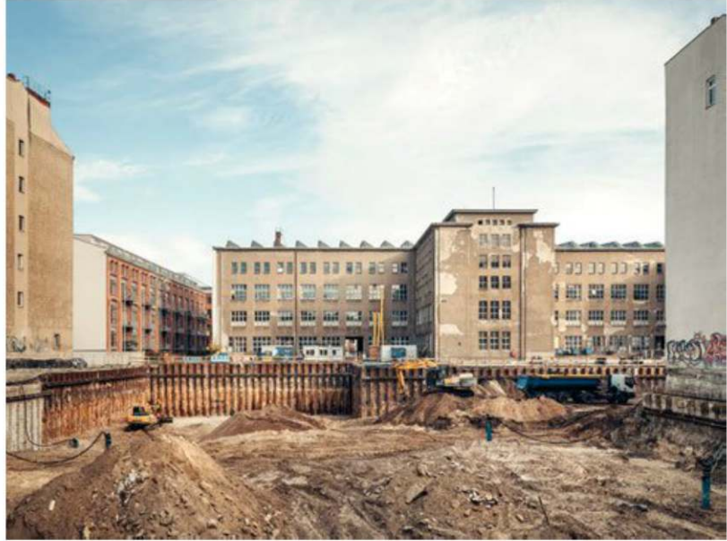
Fig. 2.10 – Inclure l'environnement de cet immeuble décrépi crée une tension frappante.
