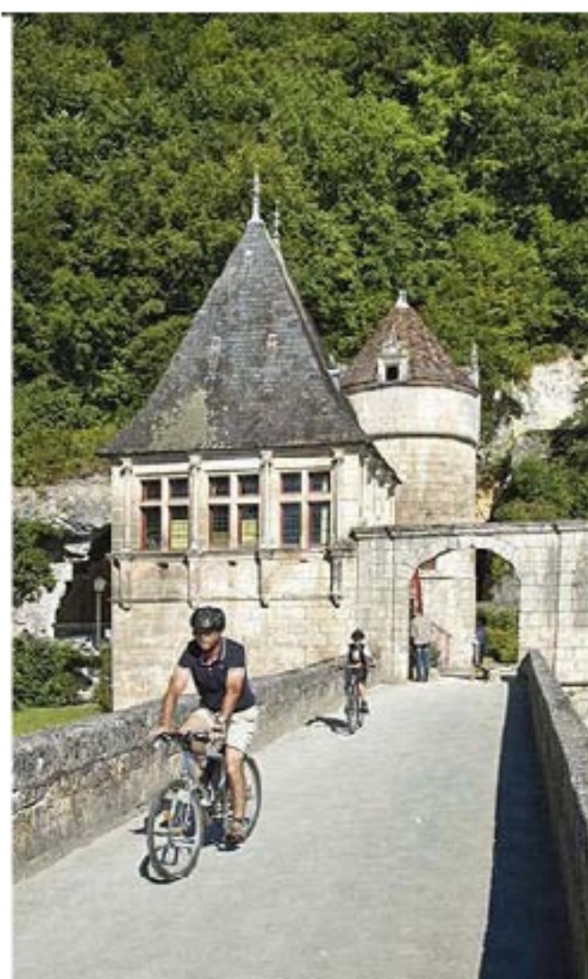
Un élégant pavillon Renaissance, remplaçant une tour défensive, marque l'entrée du pont Coudé. Derrière lui s'élève la tour Saint-Roch, du XII e siècle qui fermait au sud l'enceinte de l'abbaye.
